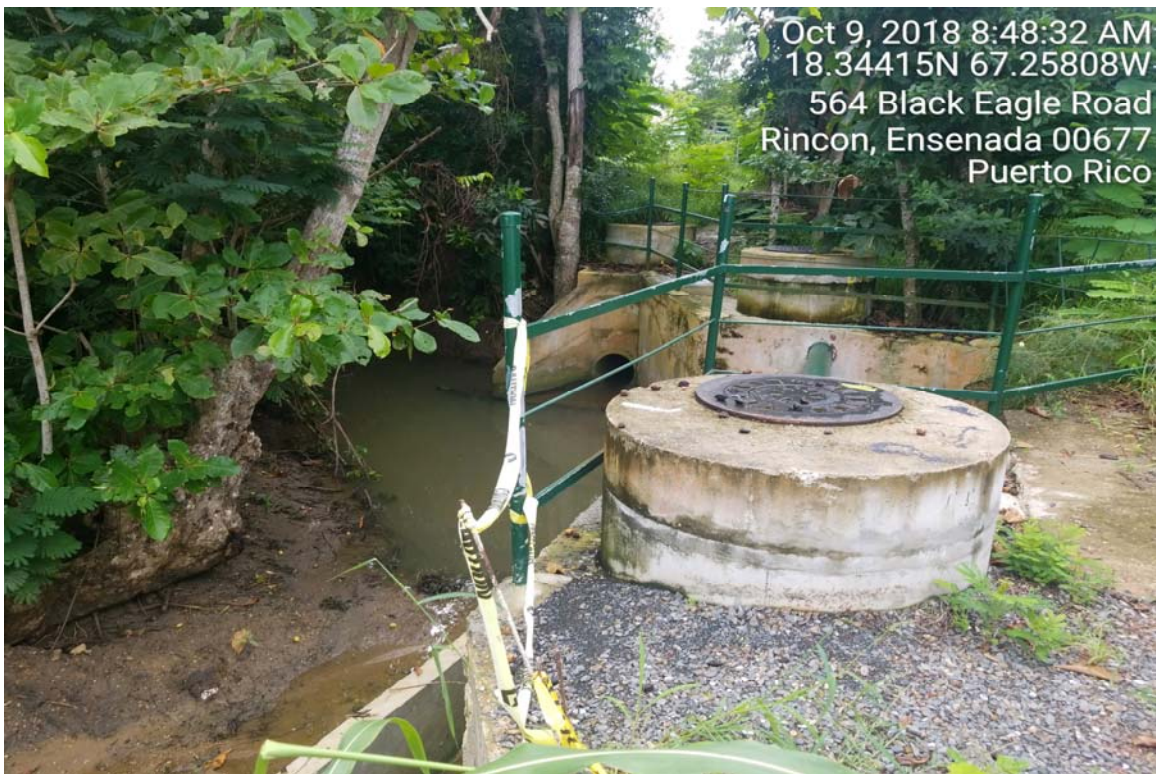
Foto 8. Vista de la Quebrada Ensenada e infraestructura existente que cruza la misma.
